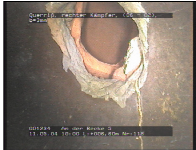
Foto 118 Videoband: 001 Zustand RQ-R 6,60 m 6 - 2 Uhr Rißbreite = 3 mm
