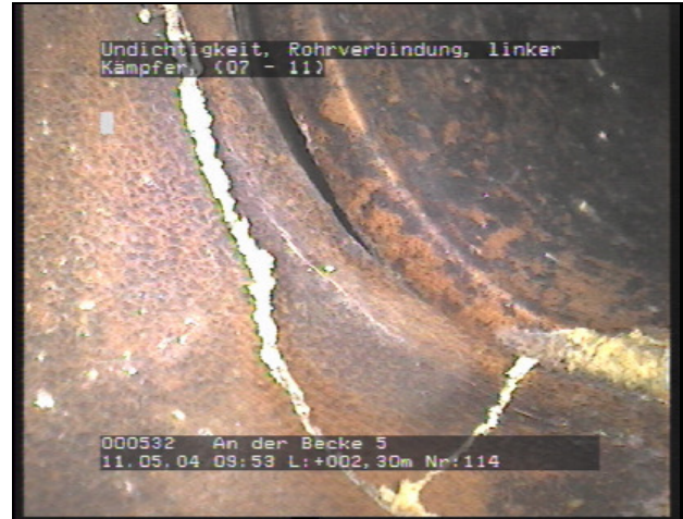
Foto 114 Videoband: 001 Zustand UC-L 2,30 m 7 - 11 Uhr
